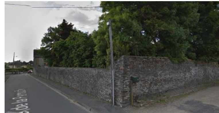
Vue du site depuis la rue de la Perruche
