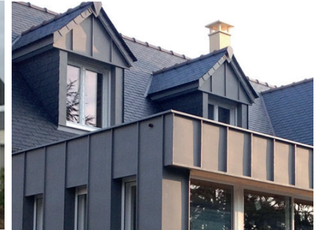
Matériaux de toiture : ardoise, zinc, autres matériaux aspect et couleur similaire
