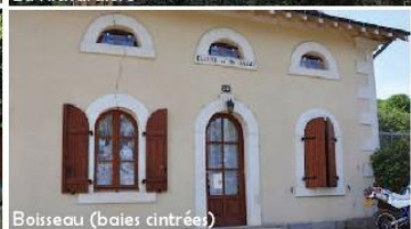
Boisseau (baies cintrées)
