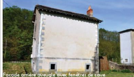
Façade arrière aveugle avec fenêtres de cave
