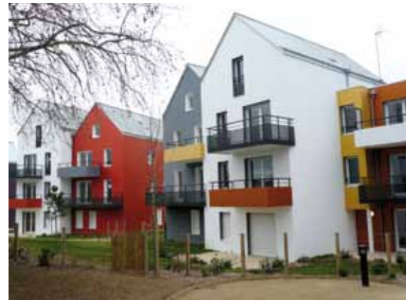
Logements dans un quartier restructuré Nantes
