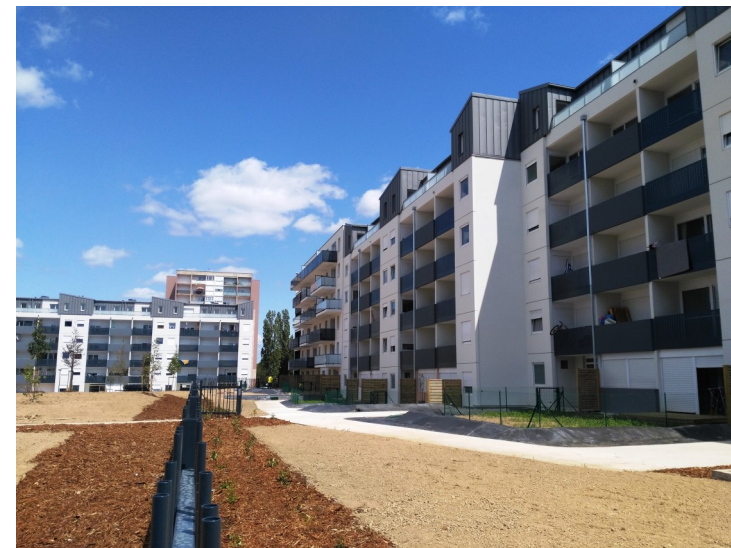
Opération Le Mortier, Méduane Habitat, 2019
