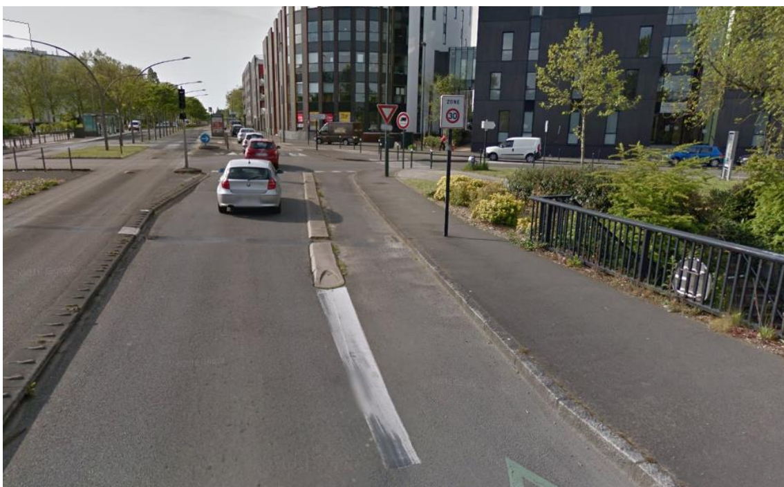
Bypass sur un giratoire à Nantes
