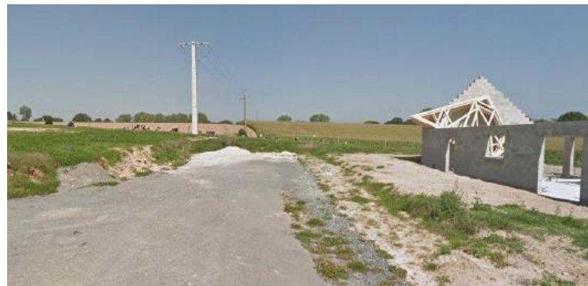
Vue du site depuis l'impasse des Iris
