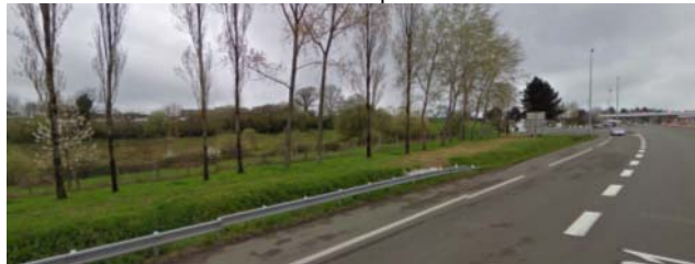
Vue sur la zone d'activités ECOPARC depuis l'A81 – une zone d'activité bien intégrée grâce aux plantations.
