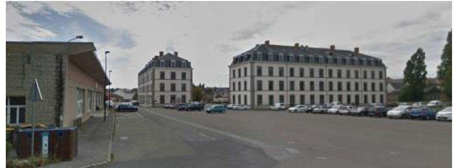
Vue de la place du Général Ferrié
