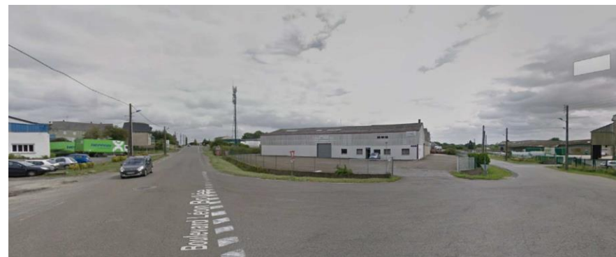
Vue du boulevard Léon Bollée
