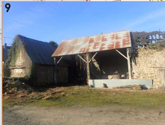
Ruine en partie mais bâtiment intégré dans un ensemble bien constitué
