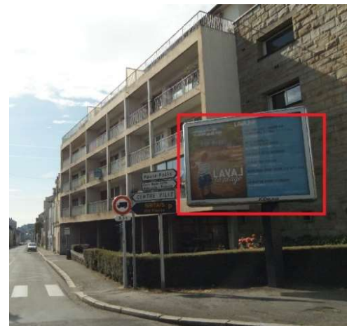
Non-respect de la règle de recul (rapport aux baies de l'immeuble voisin (d<10m))
