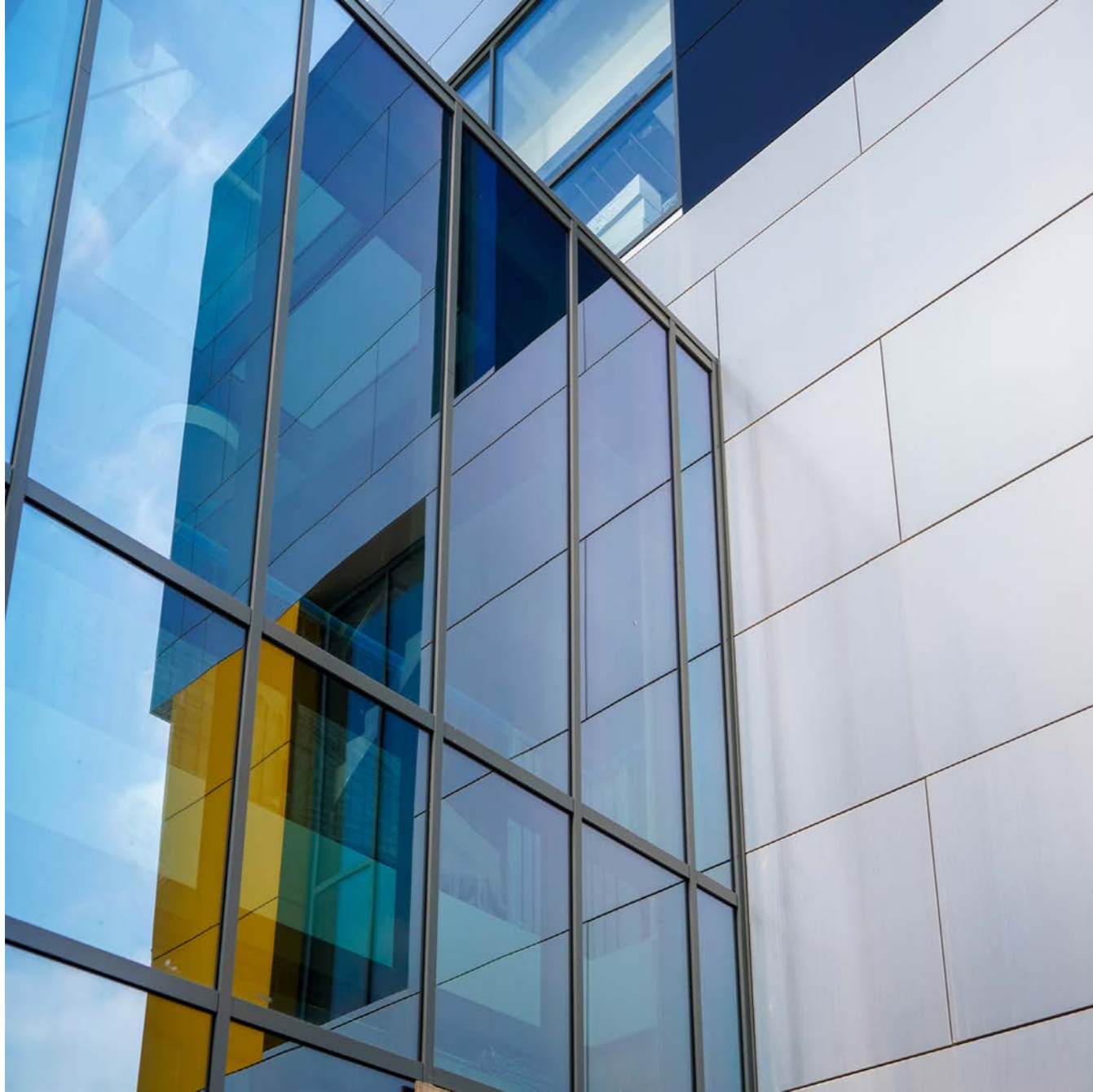
Détail de l'entrée principale (partie nouvelle) / © Laval Agglomération
