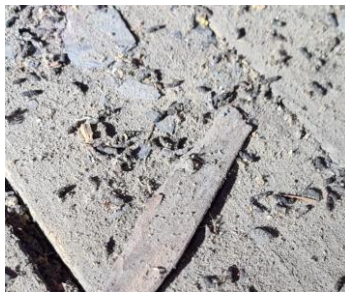
Au sol / sur l'isolant dans les combles
