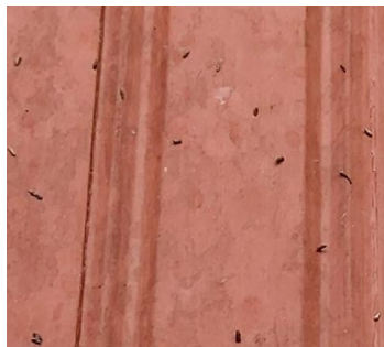
Collé à la façade
