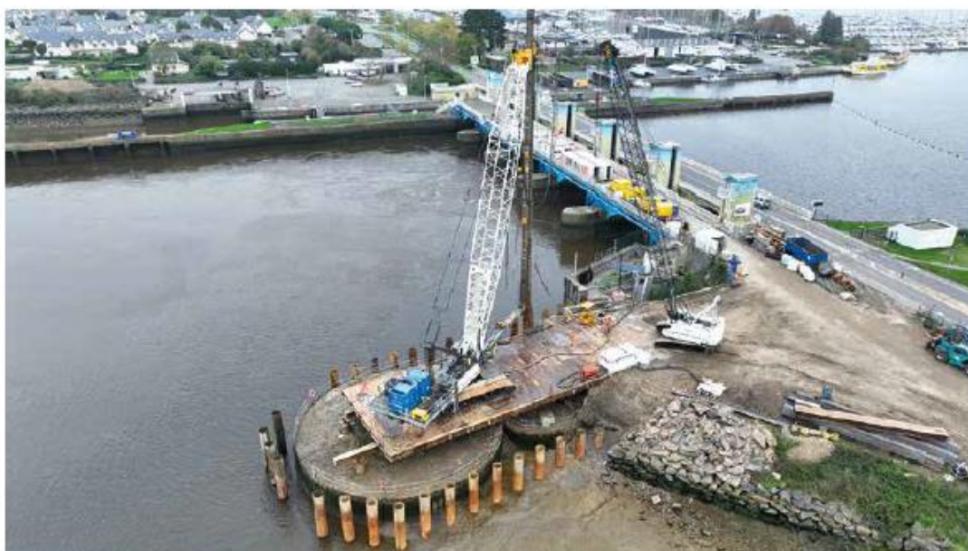
Rénovation des gabions du barrage d'Arzal (56)
