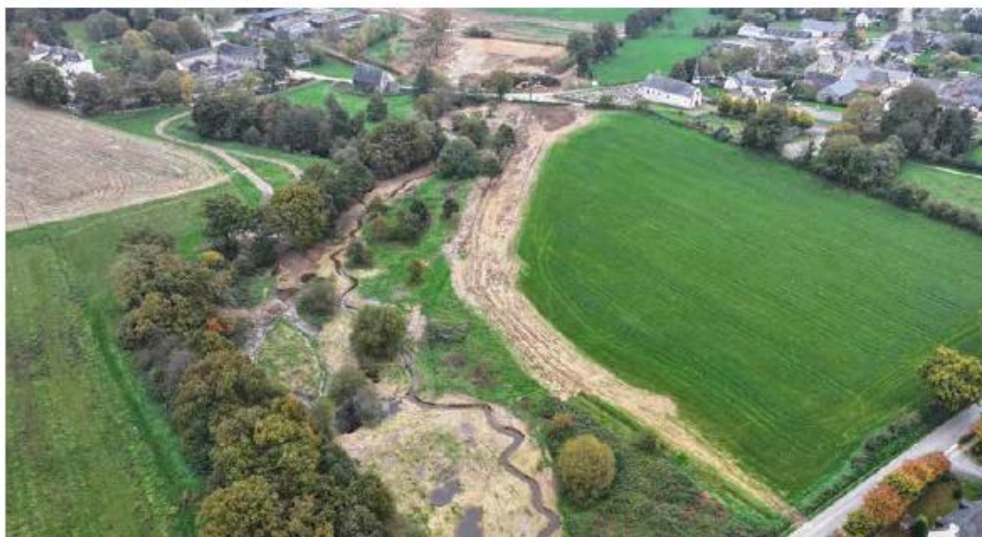
Travaux sur le ruisseau du Fresnay, à Saint-Sulpice-La-Forêt (35)
