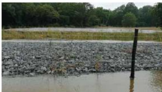
Surverse au lieu-dit La Leuve, sur la commune de Châteaubriant (44)
