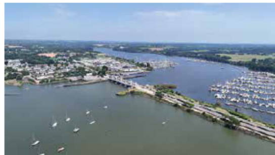
Suivi des poissons migrateurs, barrage d'Arzal (56)
