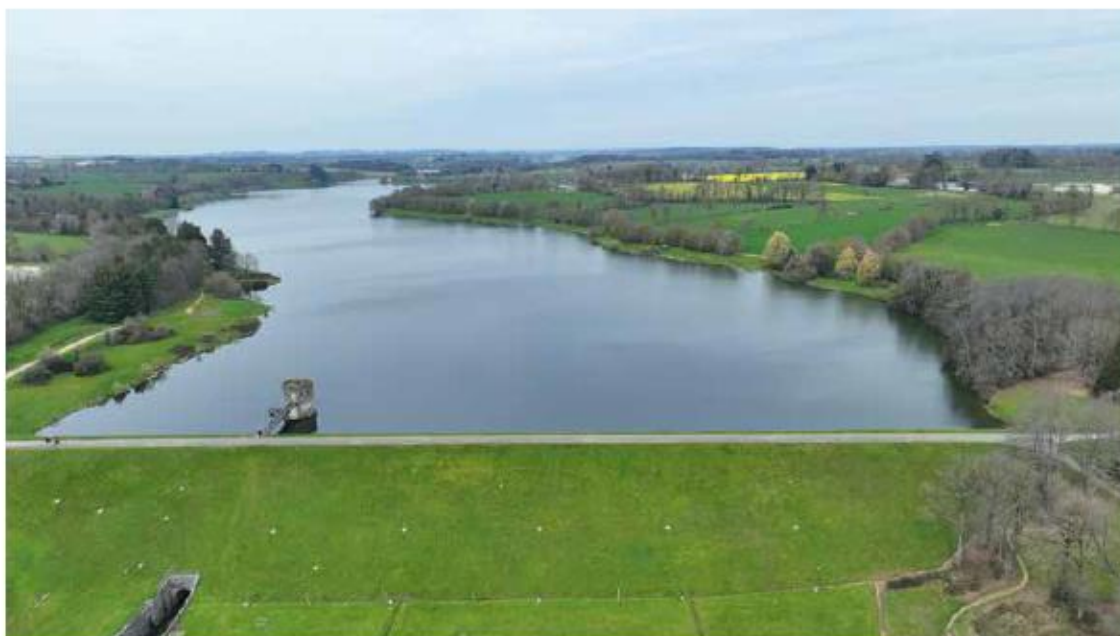
Barrage de la Valière
