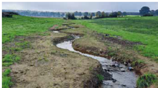
Restauration du cours d'eau de la Haute Roussière à Ercé (35)
