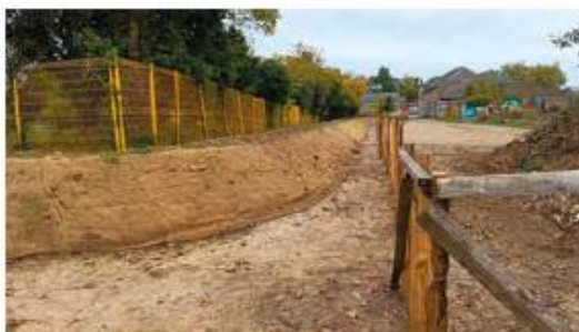
Travaux de confortement de la digue de Saint-Nicolas-de-Redon (44)
