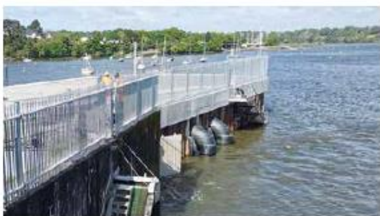
Nouvelle rampe à anguilles
