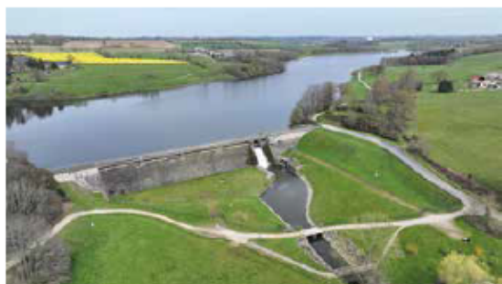
Barrage de la Cantache
