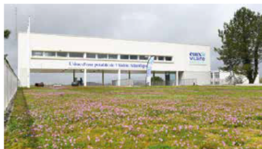
Usine de production d'eau potable de Vilaine Atlantique
