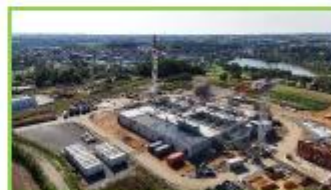
Usine des Eaux – octobre 2024
