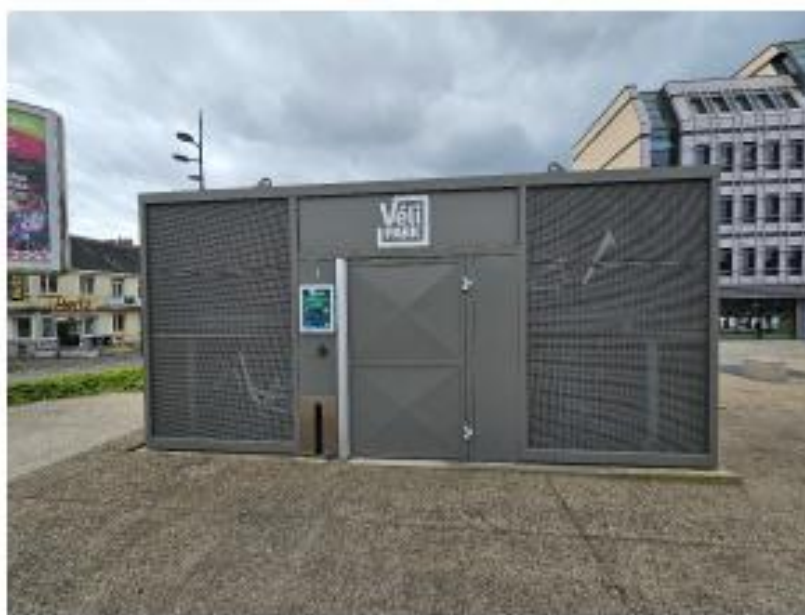
Photo du parking de la gare SNCF – Juin 2024
