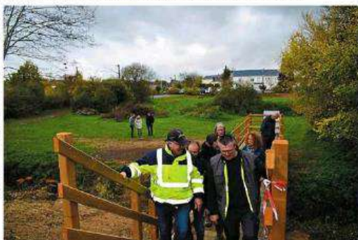
Franchissement de la passerelle construite au bassin tampon sur la rue de la Hantelle.
