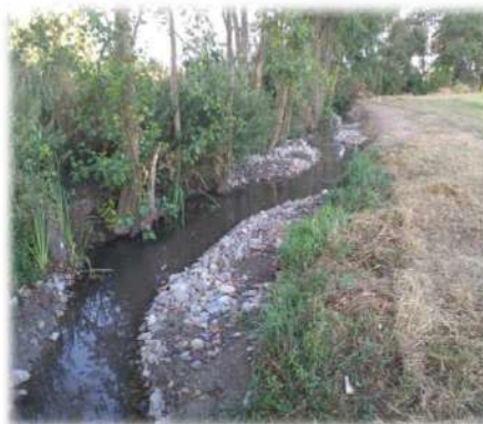
Travaux de restauration hydromorphologique de la Nymphe
