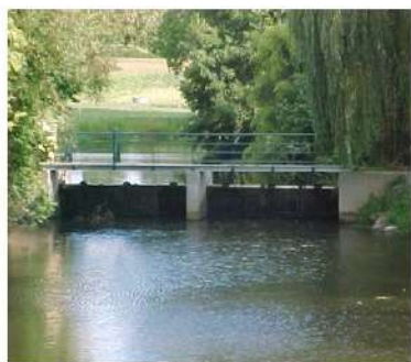
Clapets du moulin de Treize Vouges et rivière de contournement
