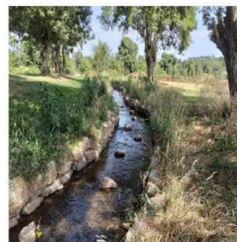
6 mois après les travaux
