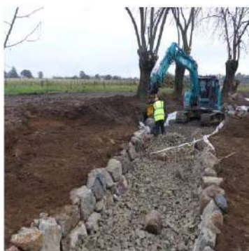
Pendant les travaux
