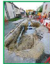
Rue du Mesnil Saint-Germain-Le-Fouilloux
