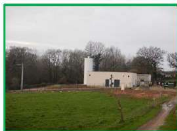
Vue d'ensemble après travaux
