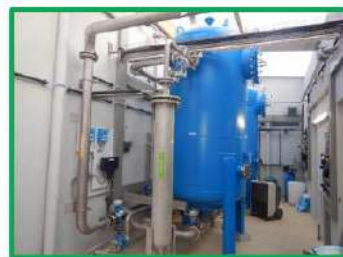
Filtres déferrisation/démanganésation
