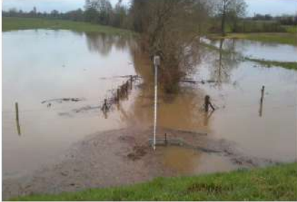
Zone d'écrêtement du barrage de Thoury (Le Tremblay) crue du 4 janvier 2022
