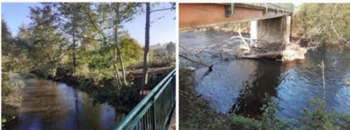
Une opération ponctuelle de retrait d'un ancien vannage sans usage a néanmoins été réalisée en aval de la RD 247 à Montenay sur le ruisseau de l'Oscence (problématique initiale d'effet « peigne » > accumulation des débris flottants créateur d'embâcle) :
