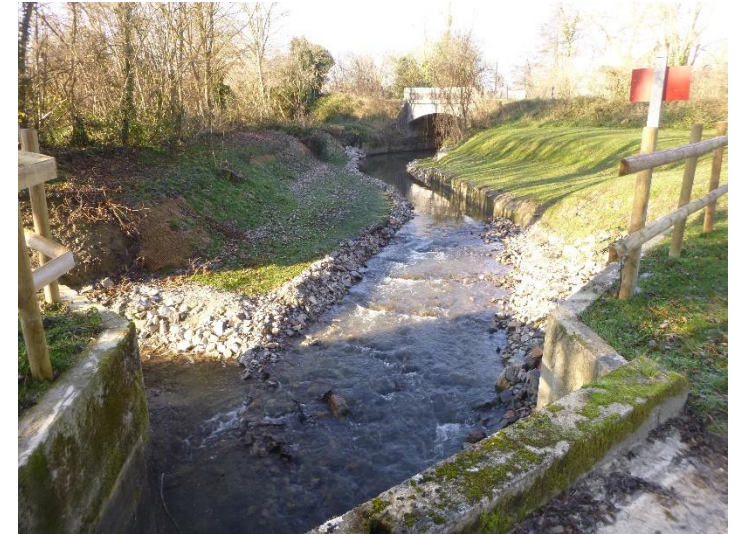
Après restauration complète ; retrait du clapet, reprofilage, reconnexion du ruisseau, restauration hydromorphologique
