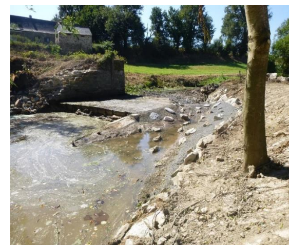
Rampe en enrochements à Sorin (Noëllet)
