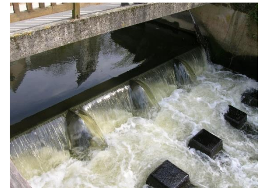
Clapet du Bourg de Craon
