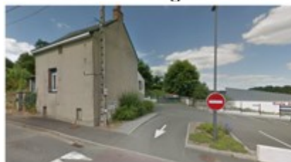
St Jean/Mayenne : Démolition et aménagement d'un terrain de 700 m2
