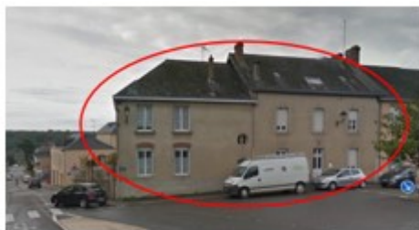
Port Brillet : logements communaux
