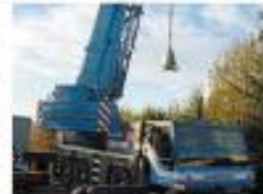
Des bornes enterrées pour collecter les déchets vont être installées rue du Rocher.
