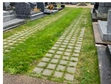
Désimperméabilisation des espaces de circulation dans le cimetière à Saint-Ouen-des-Toits
