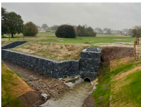
Réaménagement du bassin de la Salais au Bourgneuf-la-Forêt
