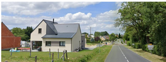
Entrée de ville à Saint-Pierre-la-Cour depuis la RD576
