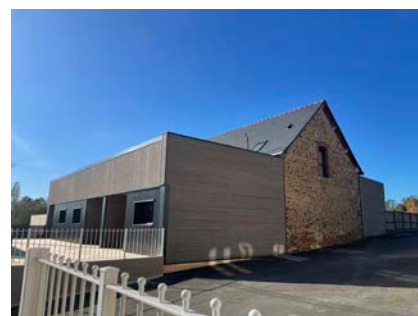
Utilisation de nouveaux matériaux à Ahuillé
