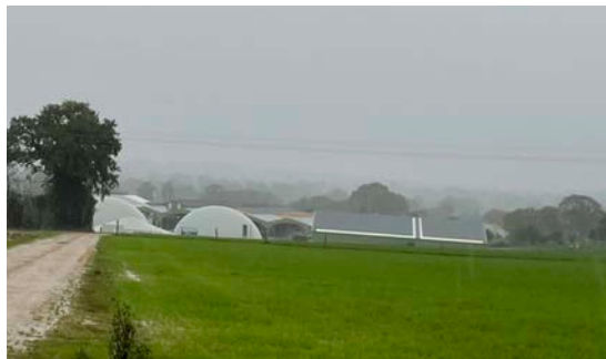
Unités de méthanisation à Châlons-du-Maine
