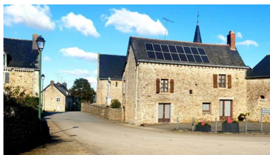
Toiture avec panneaux photovoltaïques à Saint-Cyr-le-Gravelais
