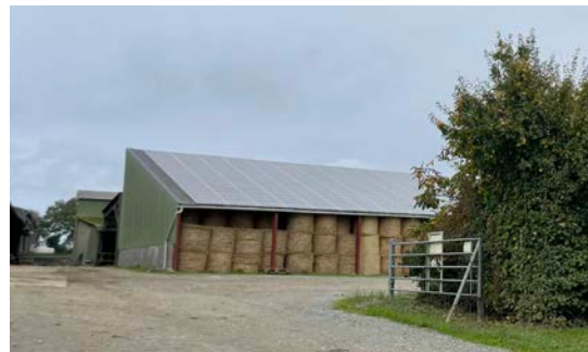
Bâtiment agricole photovoltaïque à Loiron-Ruillé
