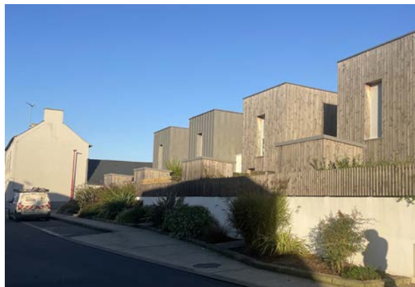
Nouveaux logements à Loiron-Ruillé
