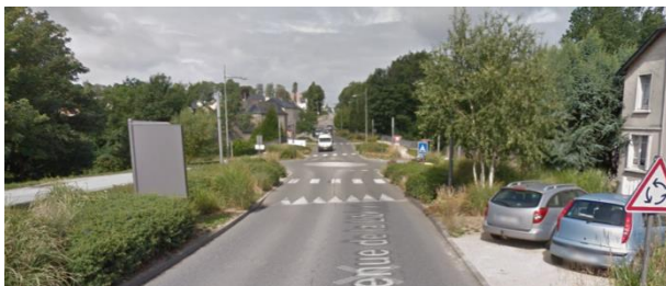
Traitement paysager de la voie en entrée de ville de St-Berthevin (franchissement du Vicoïn)
