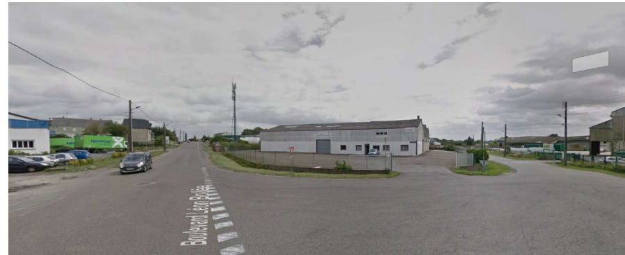
Vue du boulevard Léon Bollée
