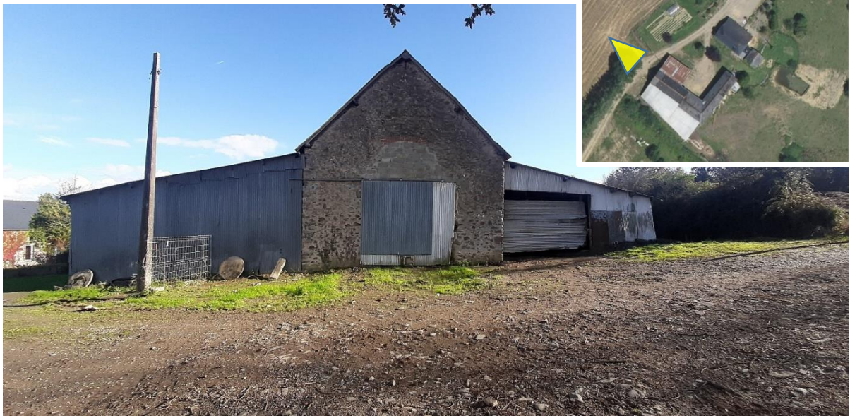
▲ Vue vers les bâtiments de stockage
