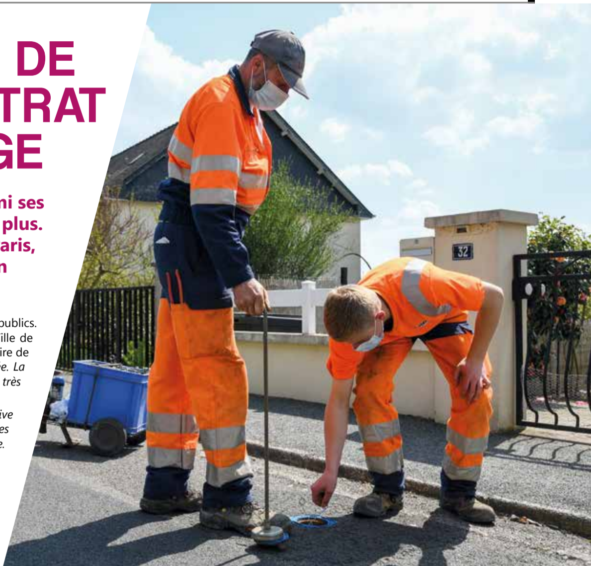
Alexis Paris en repérage de fuites sous la chaussée, en compagnie de Thierry Gehard, son maître d'apprentissage (debout).
