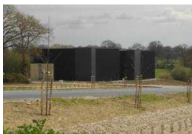
Bâtiment existant sur la ZA des Pavés
