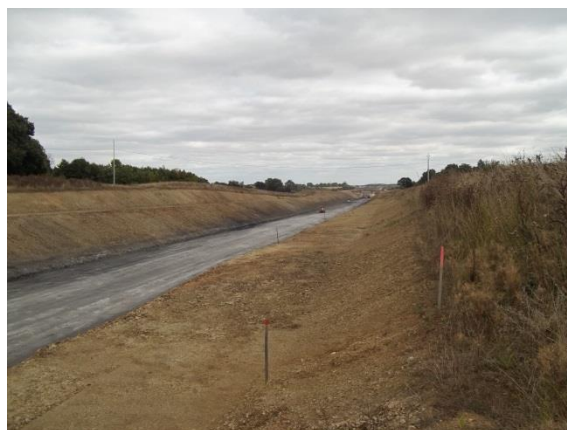
Figure 12. – Les travaux de la L.G.V. modifient en profondeur le paysage. Photo : Mathieu REBENDENNE. 2013.
