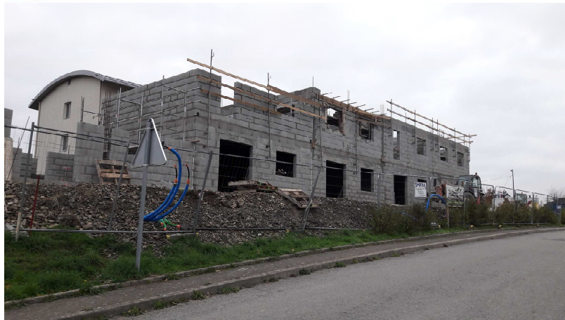
Extension de la résidence Avicenne 4 maisons de ville et 3 appartements Livraison : été 2019
