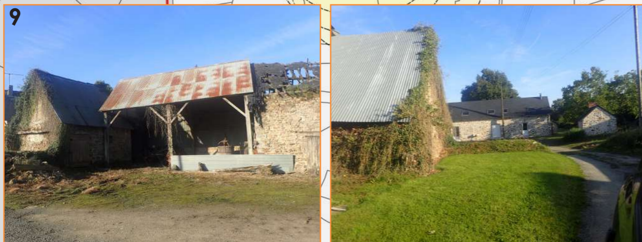
9 Ruine en partie mais bâtiment intégré dans un ensemble bien constitué
