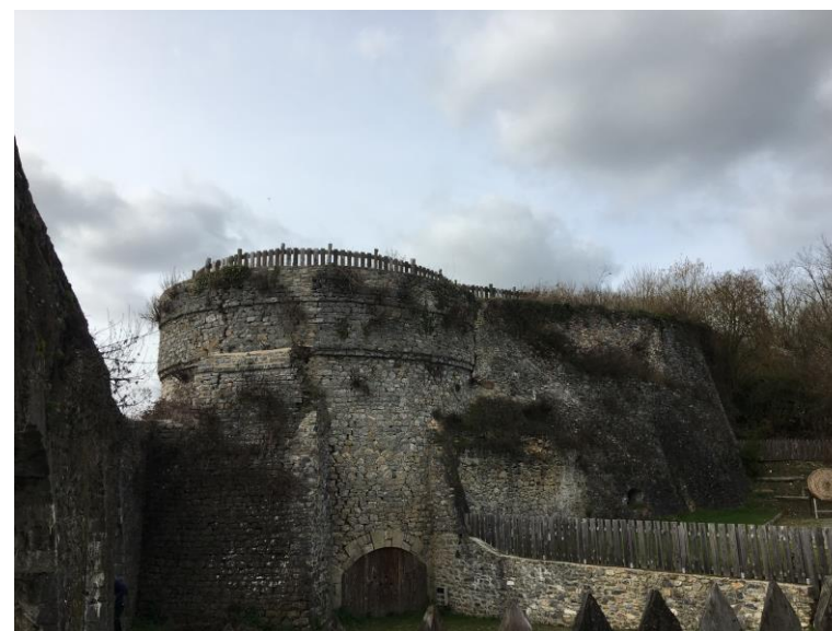
Entrée du site
