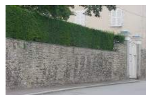
Clôture à couverture plat avec ardoises
