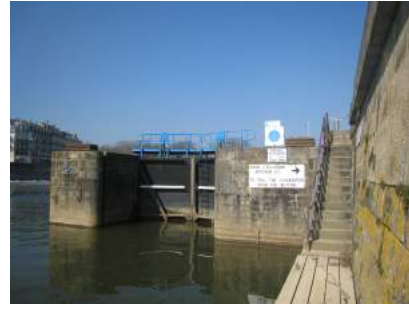
Écluse quai Paul Boudet
