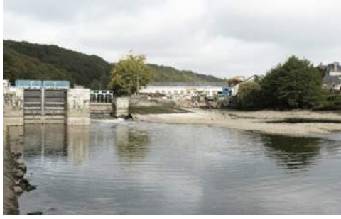
Ouvrage hydraulique de Cumont
