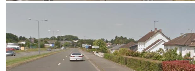
Passage de la rocade en boulevard urbain (boulevard Du Guesclin), à l'est et boulevard des Trappistines au sud de Laval) : une échelle à mi-chemin entre la voie routière et le boulevard
