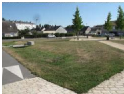
Les Pommeraies à Laval: une noue paysagère intégrée à une place publique
