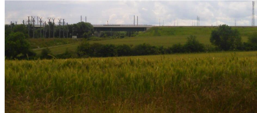
La LGV, une rupture perceptible dans le paysage, avec des volontés d'intégration ponctuelles (talus)
