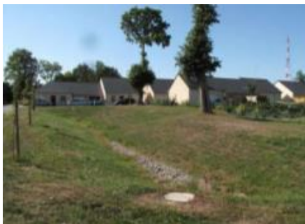
Zone du Tertre à Laval : des noues de collecte et des bassins de rétention paysagers
