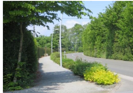
Aménagements végétaux le long de la route, permettant la sécurisation des modes doux
