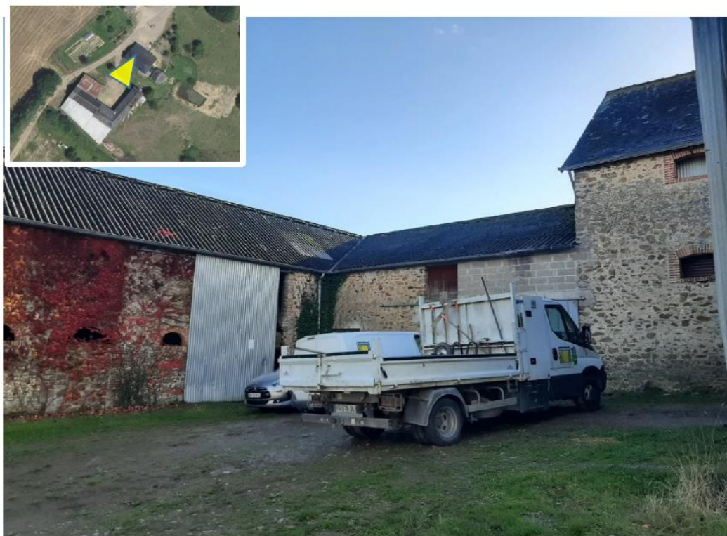
▲ Vue vers la Cour intérieure
