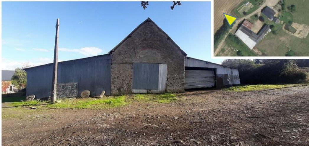
▲ Vue vers les bâtiments de stockage
