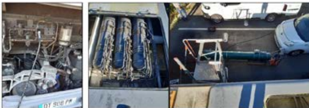
Dégazage des bus : Le reste du GPL est récupéré dans la bouteille de transvasement.
