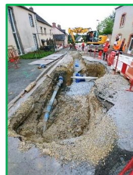
Rue du Mesnil Saint-Germain-Le-Fouilloux
