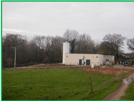
Vue d'ensemble après travaux
