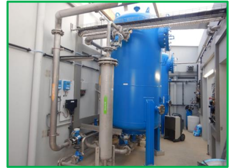
Filtres déferrisation/démanganésiation
