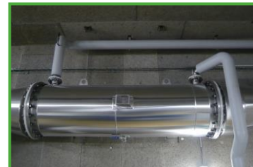
Echangeur air/eau
