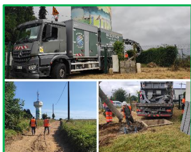
Tilleul – Pinelière à Loiron-Ruillé
