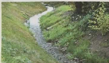
Le ruisseau de la Pelluère a retrouvé un lit plus tranquille pour limiter son débit.
