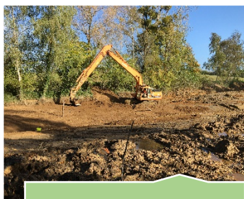
Suppr. plan d'eau de la Terrerie - LOIRON-RUILLE
