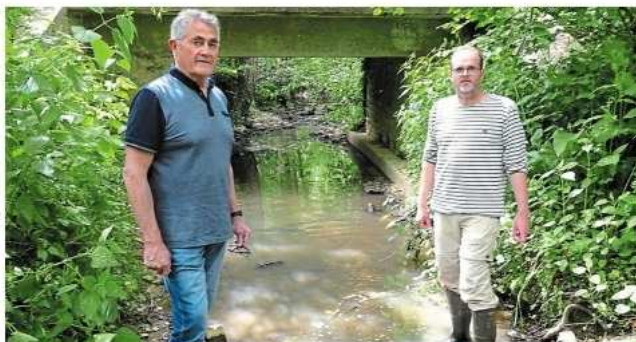
Rémy Lenormand, vice-président du Javo, et Nicolas Boileau, technicien, dans le lit de la rivière l'Ouette, au niveau du pont de Nulité-sur-Ouette, pas très loin de sa source. Un lieu où des travaux ont été effectués, notamment l'abaissement du radier du pont pour faciliter l'écoulement de l'eau, utile en période de bas niveaux.
