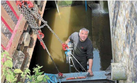
Anthony Fernandez pose et scelle dans le mur les poutres en acier qui vont supporter la pression de l'eau. Photo: Quentin
