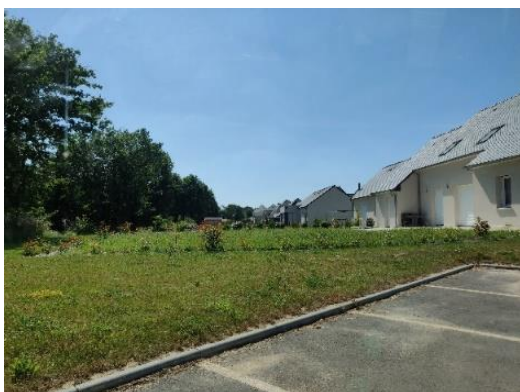
Lotissement de Longeraie, rue de Longeraie, construit à partir de 2017
