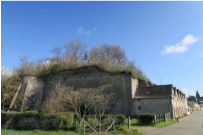
Fours à chaux (1818-1877) et habitat ouvrier (1869)
