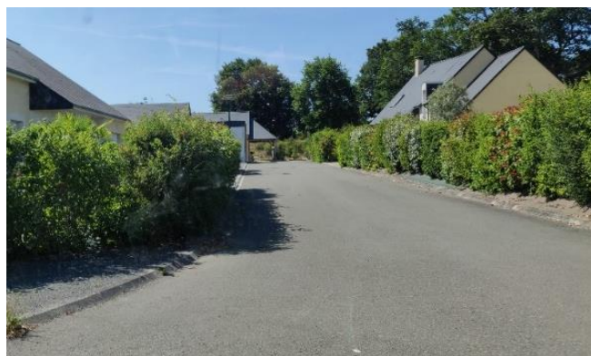
Lotissement Pré Fontaine, Impasse des Chênes, construit à partir de 2011
