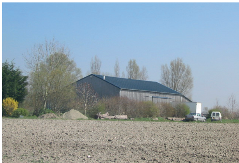
Hangar de grandes dimensions intégré par un bardage bois et quelques arbres.
