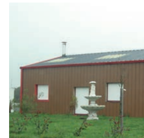
Pour une plu grande sobriété, éviter de peindre les rives d'angle des bâtiments dans des couleurs criardes
