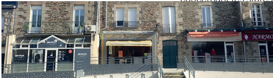
L'emploi de veranda crée des volumes inadaptés dans la composition du bâtiment
