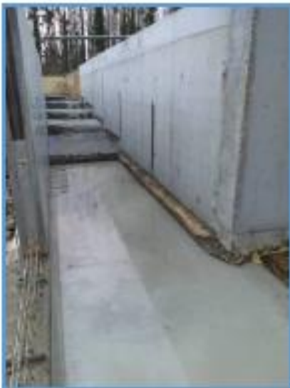
Lot n°3 : Aménagement du Moulin du Bas Coudroy au GENEST ST ISLE Construction d'une passe à bassin en génie civil
