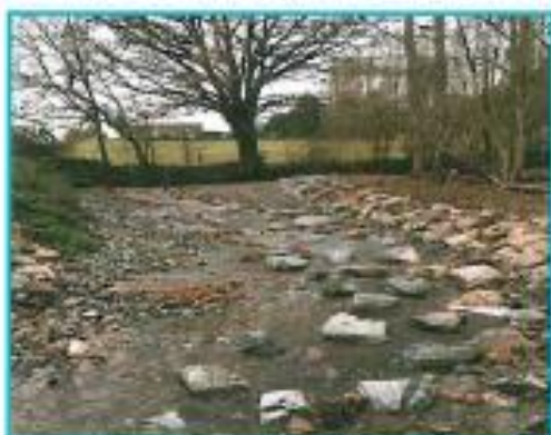
Re-création d'un bras franchissable 3 e étape des travaux sur le Bras de la Deux-Evailles
