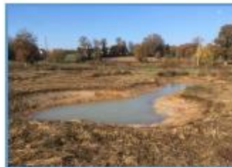
Creusement de 2 mares + Etrepage
