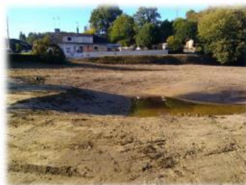
Création d'une mare à Brèges (Segré en Anjou bleu)
