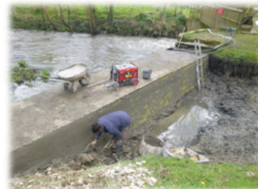
Réfection du parement amont du déversoir d'Armaillé
