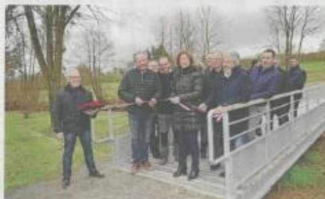
La passerelle métallique en bois de 37 m a été inaugurée le 27 Mars. Un ouvrage réalisé par l'entreprise A.F. Métallens.
