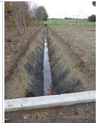
Exutoire aménagé aux Tochardières
