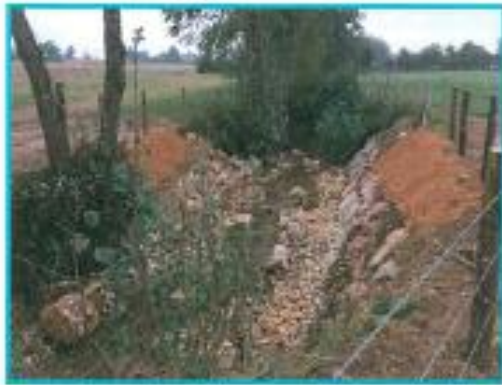
Suppression du barrage et Recharge du lit
