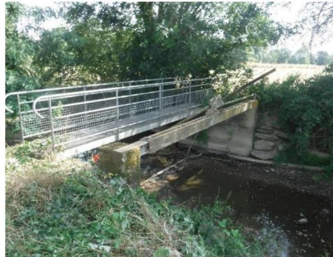
Vue de l'amont rive gauche
