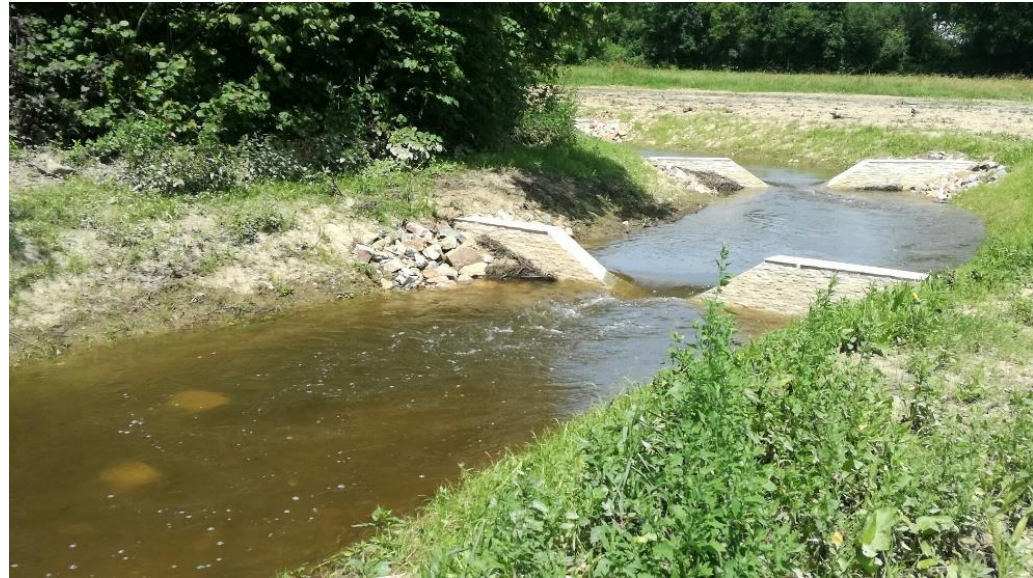
Clapets du moulin de Treize Vouges et rivière de contournement
