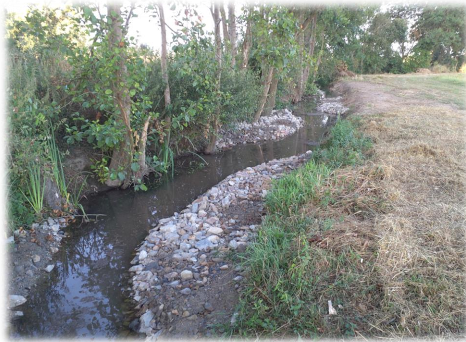
Travaux de restauration hydromorphologique de la Nymphé
