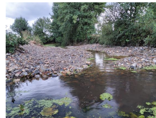
Aménagement d'un radier
