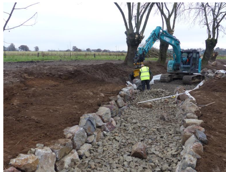
Pendant les travaux
