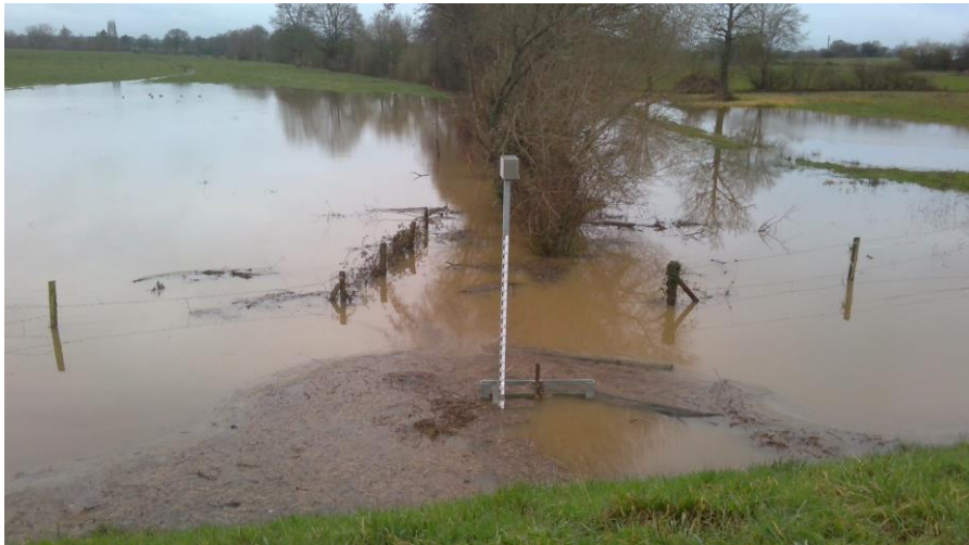
Zone d'écrêtement du barrage de Thoury (Le Tremblay) crue du 4 janvier 2022
