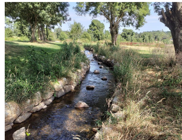
6 mois après les travaux
