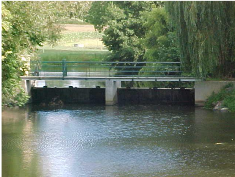
Clapets du moulin de Treize Vouges et rivière de contournement
