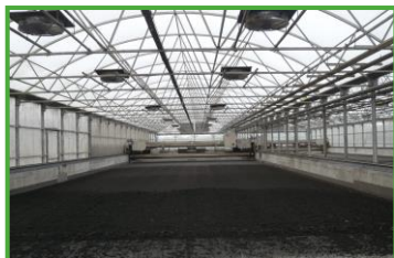
Serres de séchage des boues
