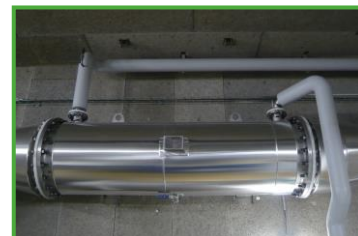
Echangeur air/eau
