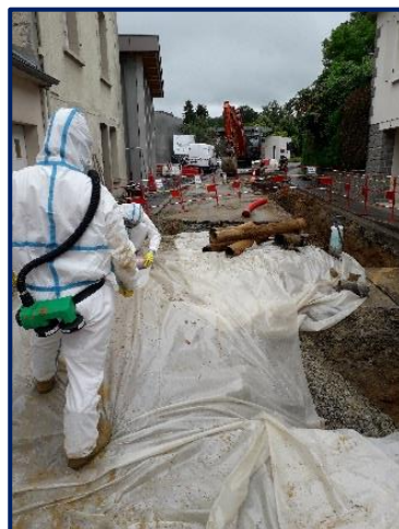
Chantier "amiante" rue Constantin Matéi à Changé
