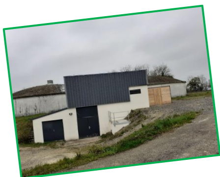
Réhabilitation de la station de refoulement des Vignes
