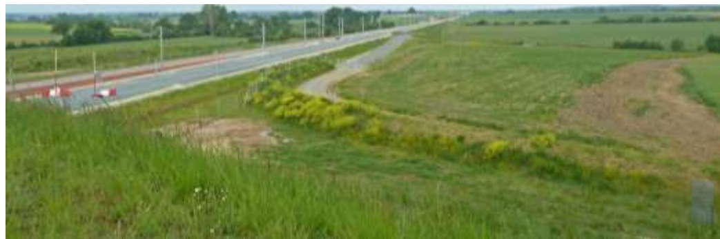
Des nouvelles infrastructures qui créent des ruptures dans le paysage, ligne LGV à Auvers-Le-Hamon
