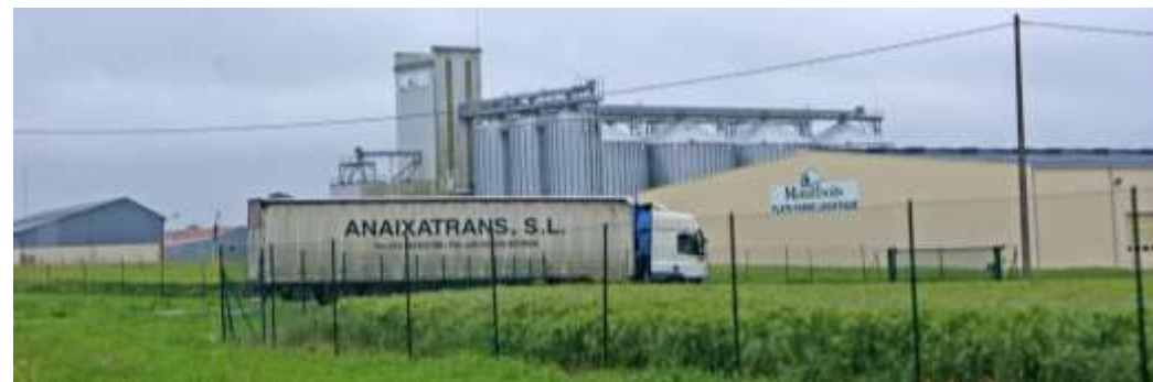
Des témoins d'une industrie agroalimentaire active : le silo de Cossé-Le-Vivien
